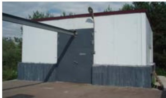
Канализационно-насосная станция АЗС №428 ОАО “Лукойл”
